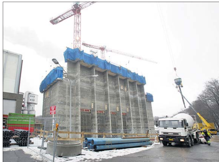
Die Bauarbeiten zum Neubau der Abfallverbrennungsanlage sind bereits in vollem Gange. (FOTOS: MARC WILWERT)
