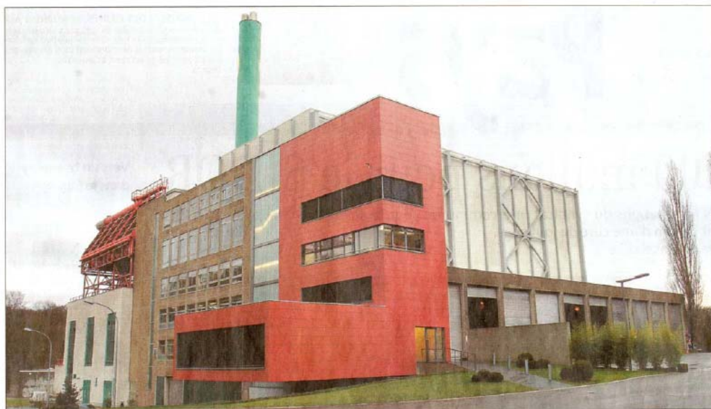
Le SIDOR est victime du poids des ans et les installations de cette usine d'incinération de Leudelange doivent être modernisées.
